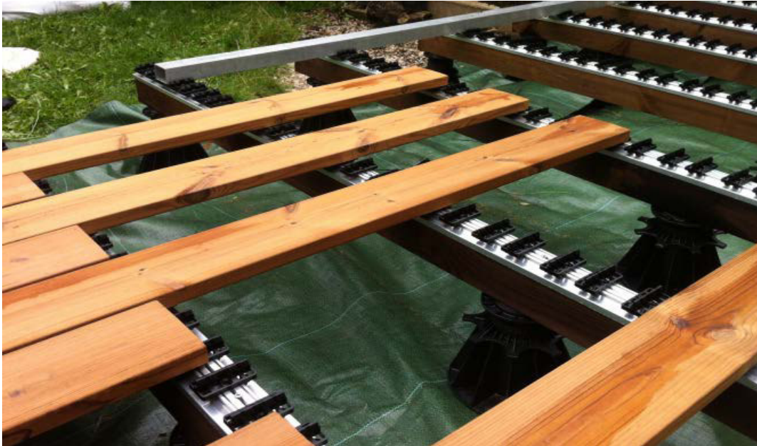
Figur 6: Aufsicht Unterkonstruktion KIT 50 verwendet als Abdeckprofil auf einer Holzstruktur mit Auflagefüße (Foto Grad™)
